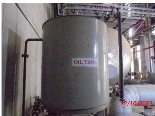
รูปที่ 2-65 Emergency Gravity Oil Tank
