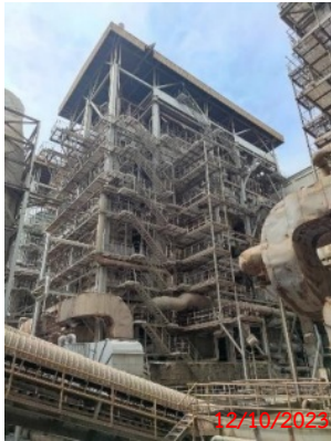
รูปที่ 2-52 อาคาร CFBC Boiler ที่มีทางเดินและบันได พร้อมราวกันตก
