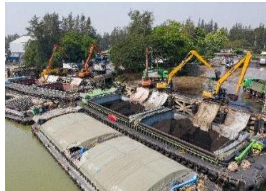
รูปที่ 2-35 การปูผ้าใบระหว่าง เรือ Barge และท่าเรือ
