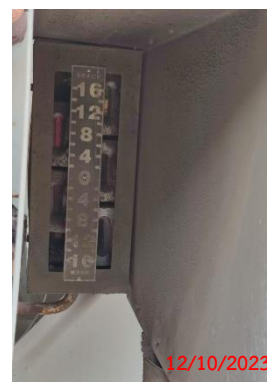
รูปที่ 2-61 เครื่องวัดระดับน้ำของหม้อไอน้ำ
