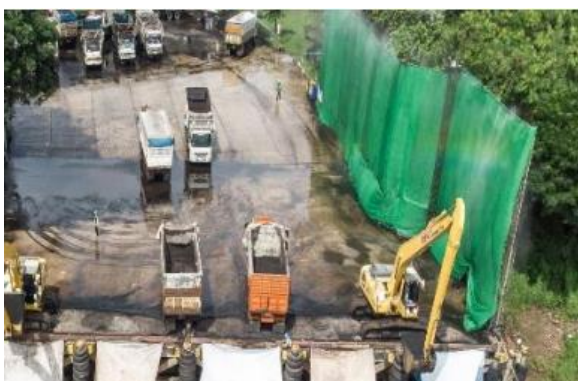
รูปที่ 2-38 การติดตั้งตาข่ายกันฝุ่นละออง
