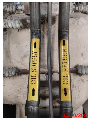
รูปที่ 2-64 ระบบท่อน้ำมันเลี้ยงแบร์ริง ของ Turbine&Generator
