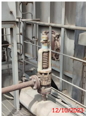
รูปที่ 2-54 Safety Valve ของหม้อไอน้ำ
